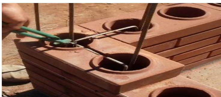
Figura 5: Amarração com ferragem em “U”.
