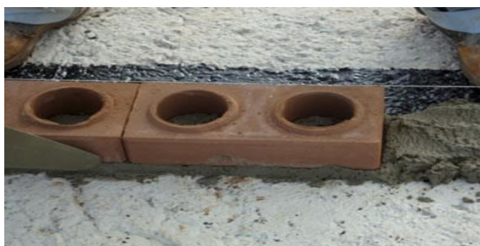
Figura 3: Primeira fiada sobre argamassa convencional.
