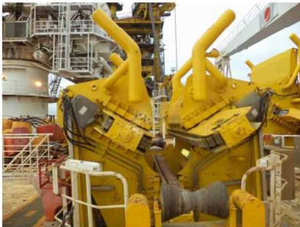
Figura 25: Embarcação PLSV Seven Oceans da empresa Subsea 7 realiza lançamento de dutos rígidos
