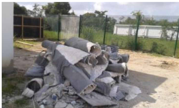
Figura 6 - Resíduo Sólido Classe C acondicionado incorretamente
