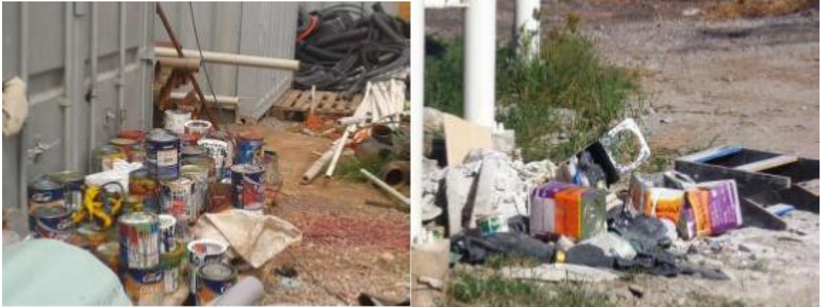
Figura 8 - Resíduo Sólido Classe D acondicionado incorretamente
