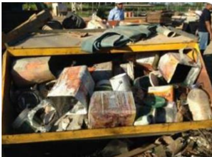
Figura 11 - Acondicionamento correto de Resíduos Sólidos Classe D
