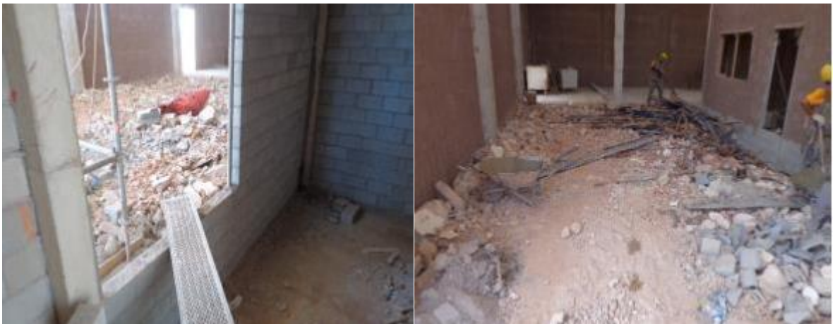
Figura 12 - Reutilização de Resíduos Classe A como agregado para enchimento do piso
