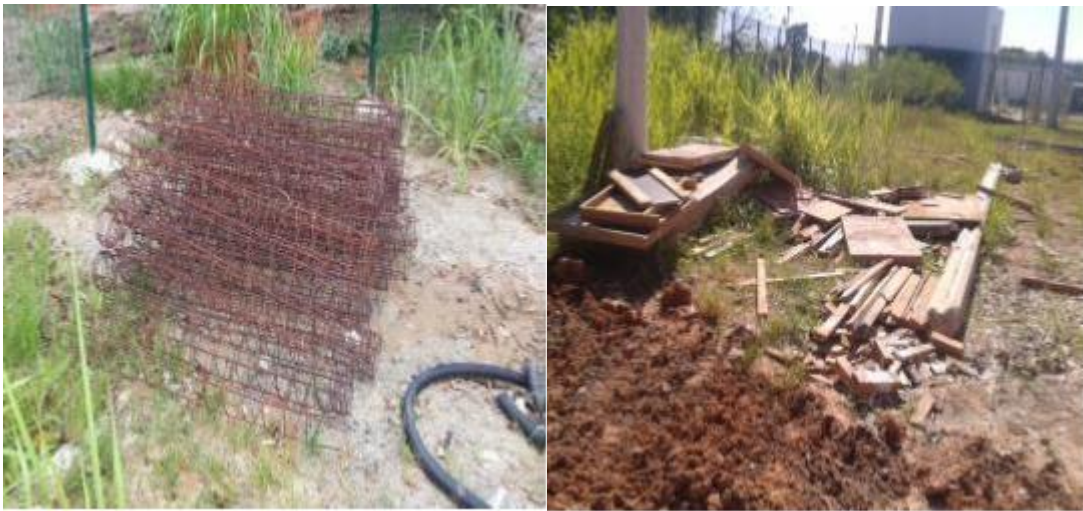
Figura 7 - Resíduo Sólido Classe B acondicionado incorretamente
