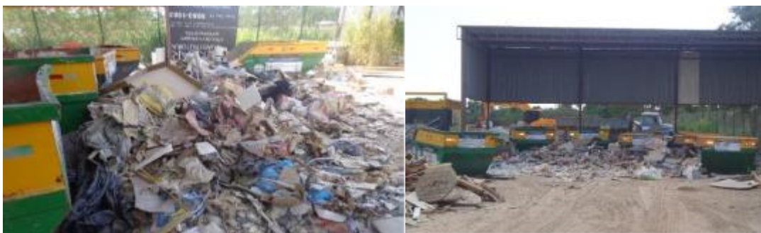
Figura 1 - Resíduos sólidos misturados na central de resíduos do canteiro
