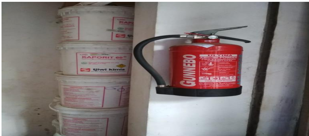
Gambar 2 : Alat pemadam kebakaran di UPTD Gudang farmasi Kabupaten Ende
