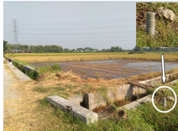
Gambar 2. Saluran irigasi yang kering walaupun pada musim hujan, juga ada sumur pipa buatan dekat saluran irigasi.
