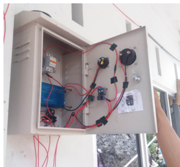
Gambar 3. Dokumentasi pemasangan panel hubung
