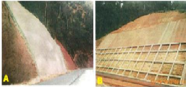
Photos 7 : A- talus stabilisé par la technique de béton ; B-Talus stabilisé par la méthode du béton projeté et la méthode d'armement dusol par des poutrelles sur la nationale N° 1 Pointe-Noire / Brazzaville © Bassoukissa (2012)
