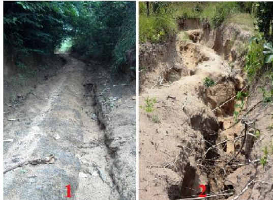
Photo 1 : Piste incisée par l’orniérage vers Mayala ; Photo 2 : Ornières transformées en ravines par les ruissellements sur la piste de Kibossi © Idriss M’bouka Milandou, 2014
