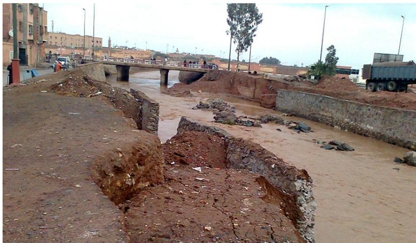
Photo 2: Affouillement d’une berge de la rive gauche d’Issil et endommagement du mur de protection
