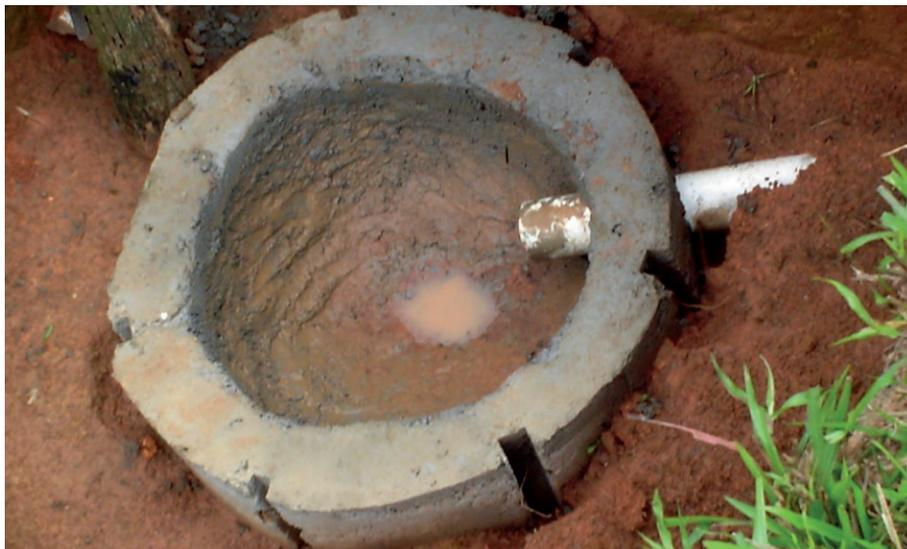
Figura 2. Detalhe da construção no local do fundo do reator
