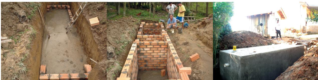
Figuras 12, 13, e 14 . Sequência da instalação do sistema coletivo Laguna
