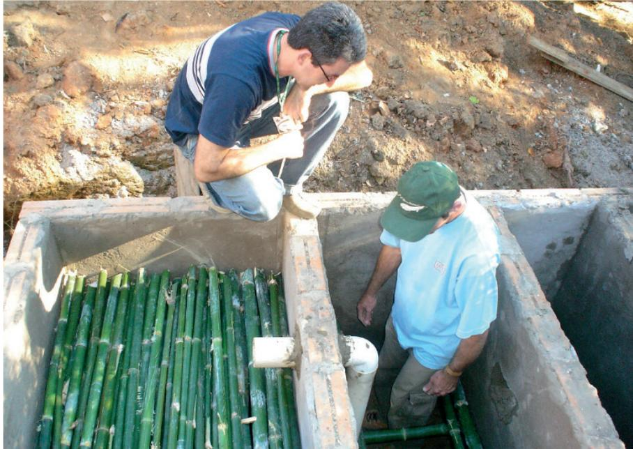
Figura 10. Detalhe da colocação do bambu inteiro no sistema
