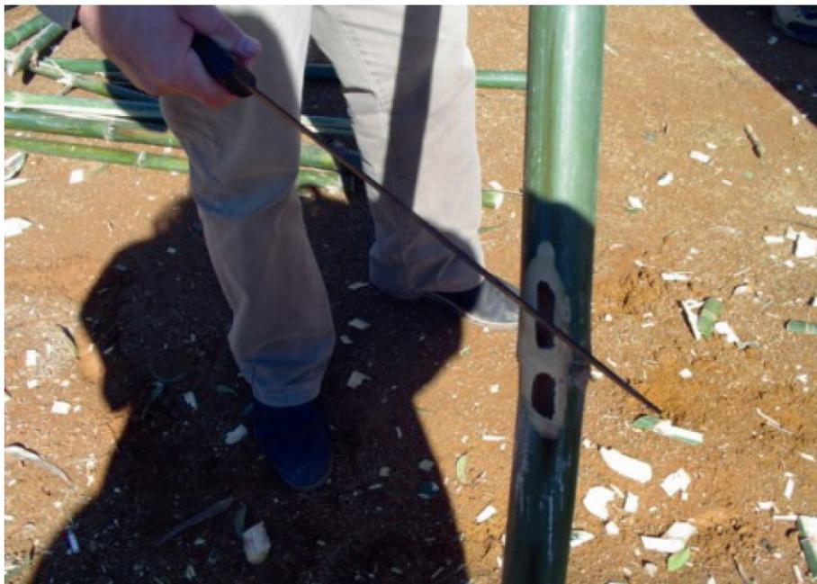
Figura 11. Detalhe do corte nos nós do bambu
