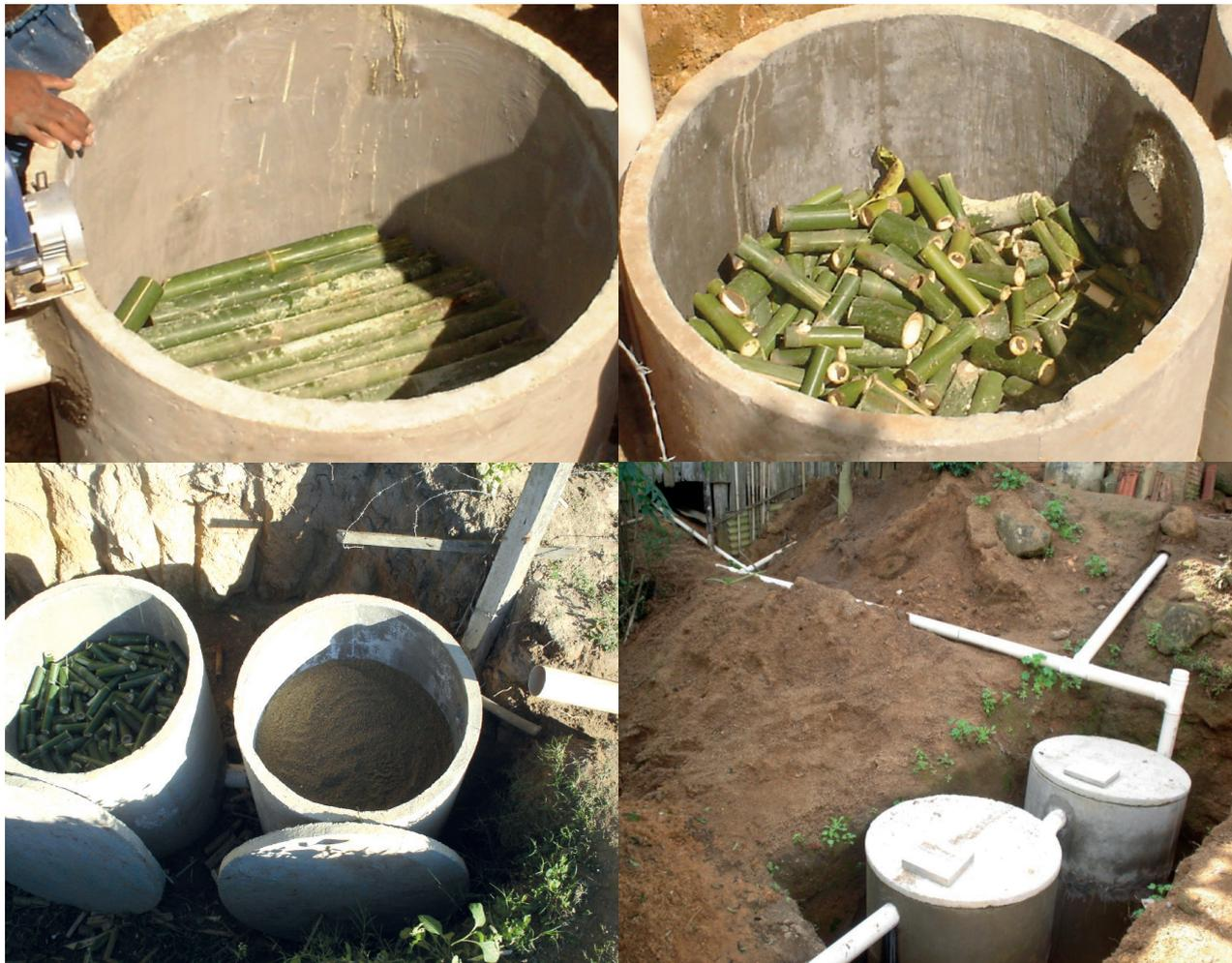
Figuras 3, 4, 5 e 6. Sequência de instalação do reator duplo com areia
