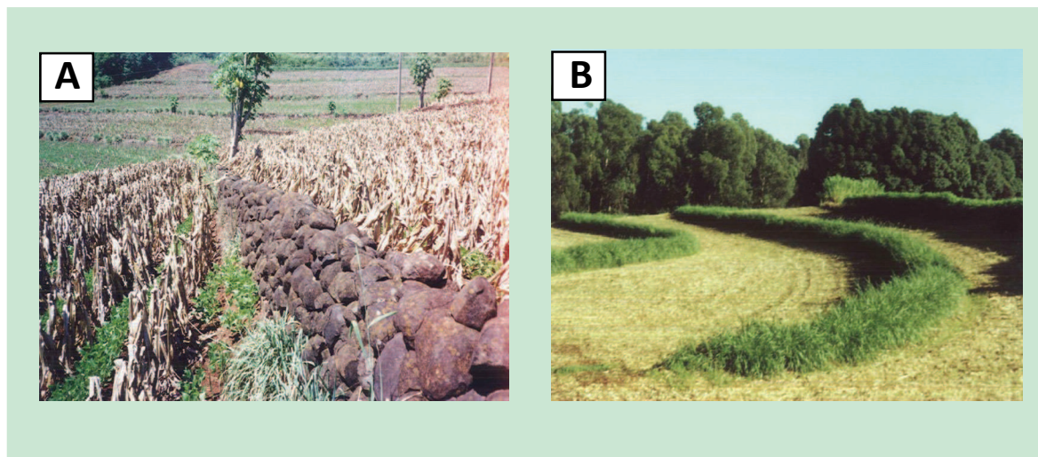
Figura 27. Cordões construídos em nível para reduzir a erosão: A) de pedra; e B) vegetado. Fonte: Acervo de Leandro do Prado Wildner
