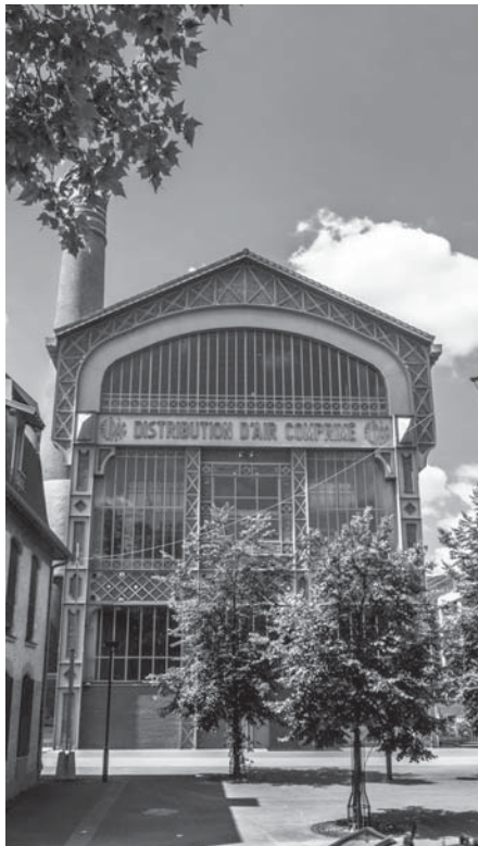
Figura 5. Fachada principal de la SUDAC. Fuente: Elaboración propia.
