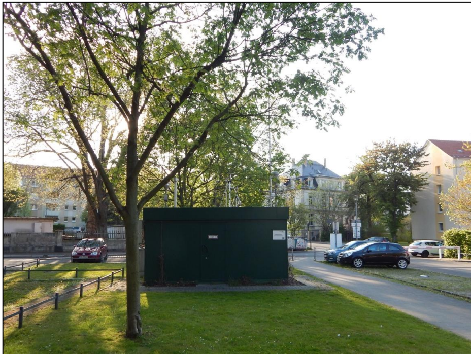
Abbildung 191: Messstation Winckelmannstraße in Blickrichtung Westen (29.04.2017) (Quelle: Eigene Darstellung)
