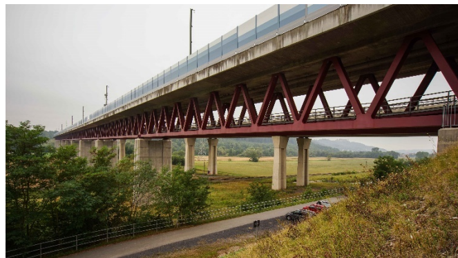
Abbildung 1: EÜ Itztalbrücke (im Vordergrund) [Wen18].
