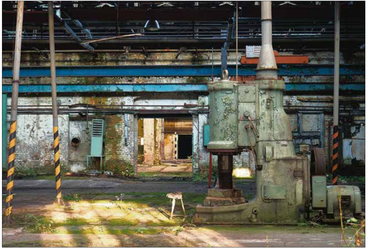
Blick in die Halle eines ehemaligen Reichsbahnausbesserungswerkes.
