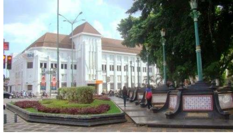
Gambar 5. View bangunan Indis yang ditawarkan ruang publik kawasan titik nol Kilometer bagian barat Sumber: Dokumentasi Pribadi, 2017
