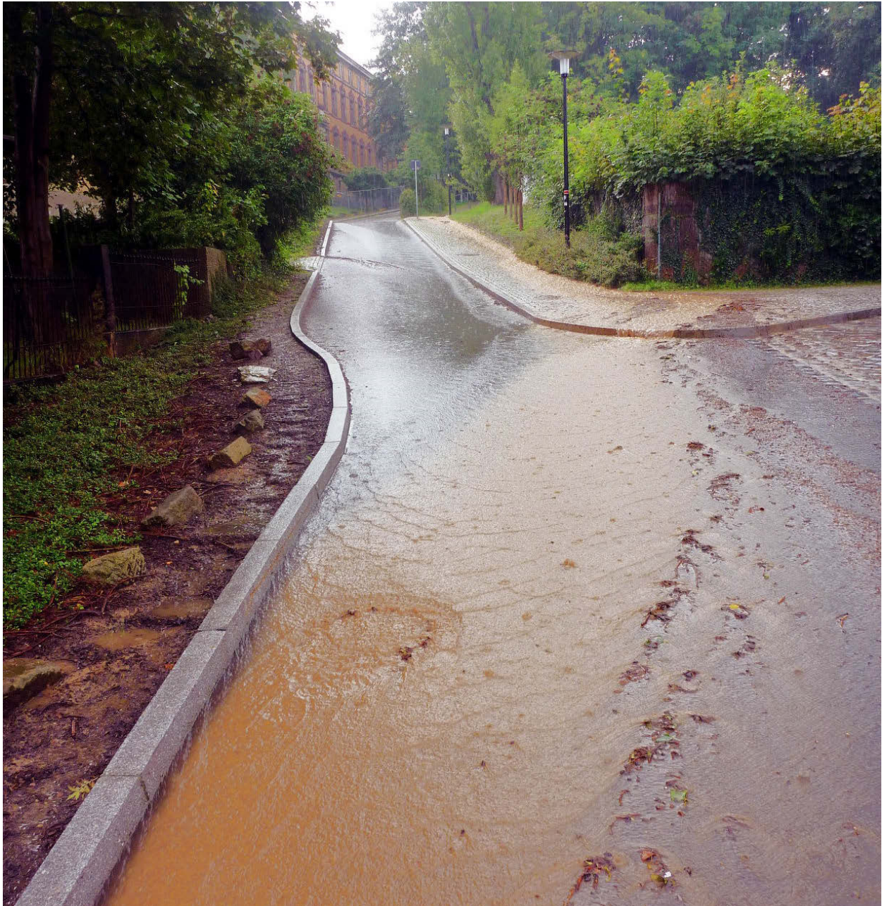
Bild 3-5: Beispiel für den Eintrag von Erdreich in die Kanalisation bei einem Starkregenereignis (Dresden-Plauen, 2013).
