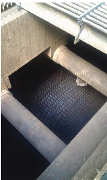
Abbildung 1.2: Kühleinbauten im Kühlturm Boxberg, Werk IV
