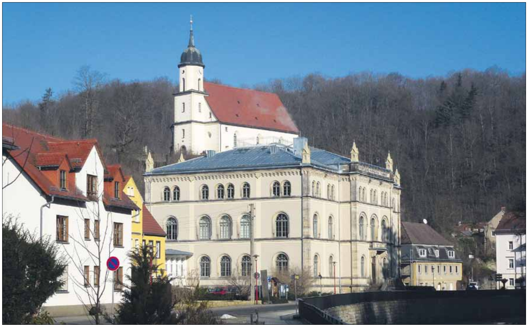
Der Altbau der Fachrichtung Forstwissenschaften an der Piener Straße in Tharandt im Februar 2015. In den vergangenen sechs Jahren wurde er denkmalgerecht rekonstruiert. Fotos (2): Wienhaus
