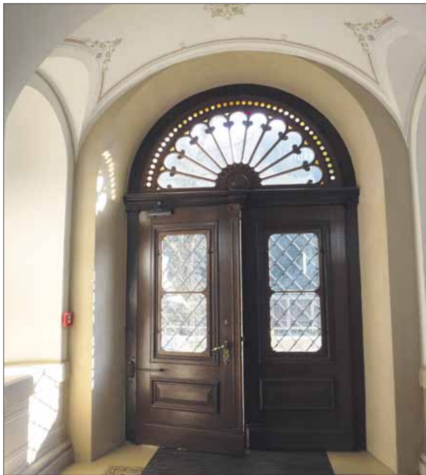
Auch der Eingangsbereich des Altbaus wurde rekonstruiert.
