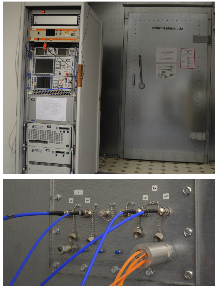
Abbildung 1.5: MVK der TU Dresden - Messgeräte und Durchführungsplatte
