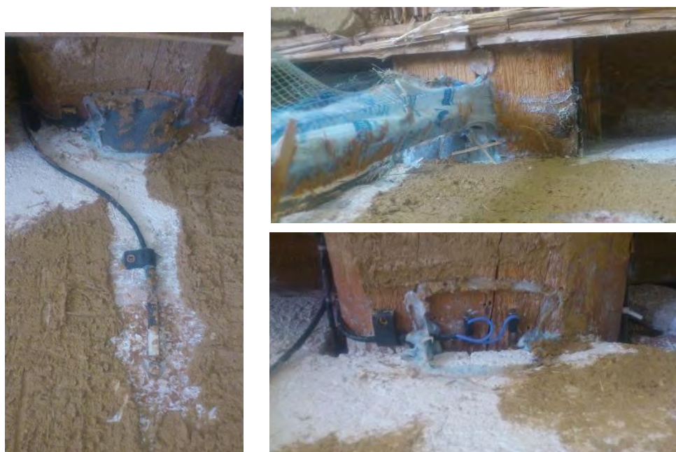
Abb. 31 Schilfdämmung: links Luftfeuchte-/Temperatur-Sensor am Übergang Bestandputz-Dämmung, rechts oben Abziehen des Putzanschlussbandes bei luftdichtem Verschluss an Balken 6, rechts unten die beiden Nagelköpfe der Holzfeuchtemessung
