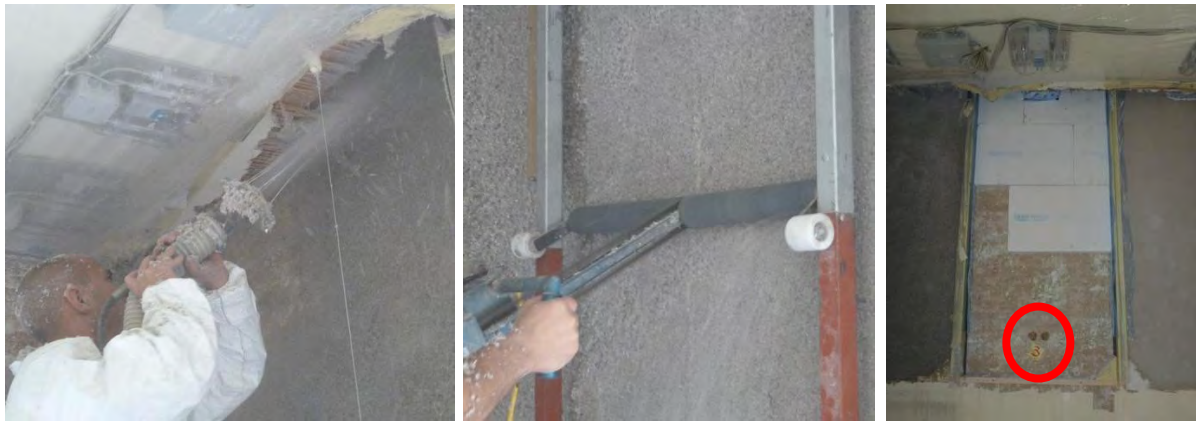
Abb. 14 Feld 1, Balken 1 & 2: Aufspritzen der bindemittelverstärkten Zellulosedämmung
