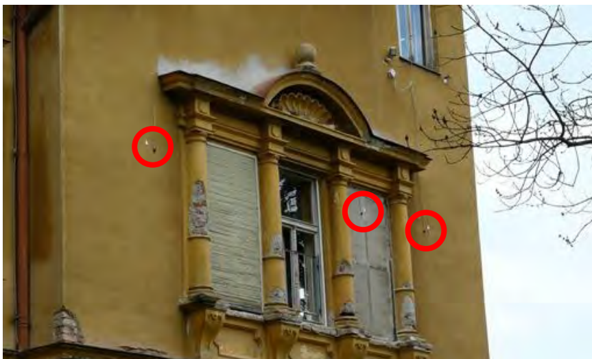
Abb. 71 Positionen der Oberflächentempersensoren auf der nach Südwestsüd ausgerichteten Außenwand
