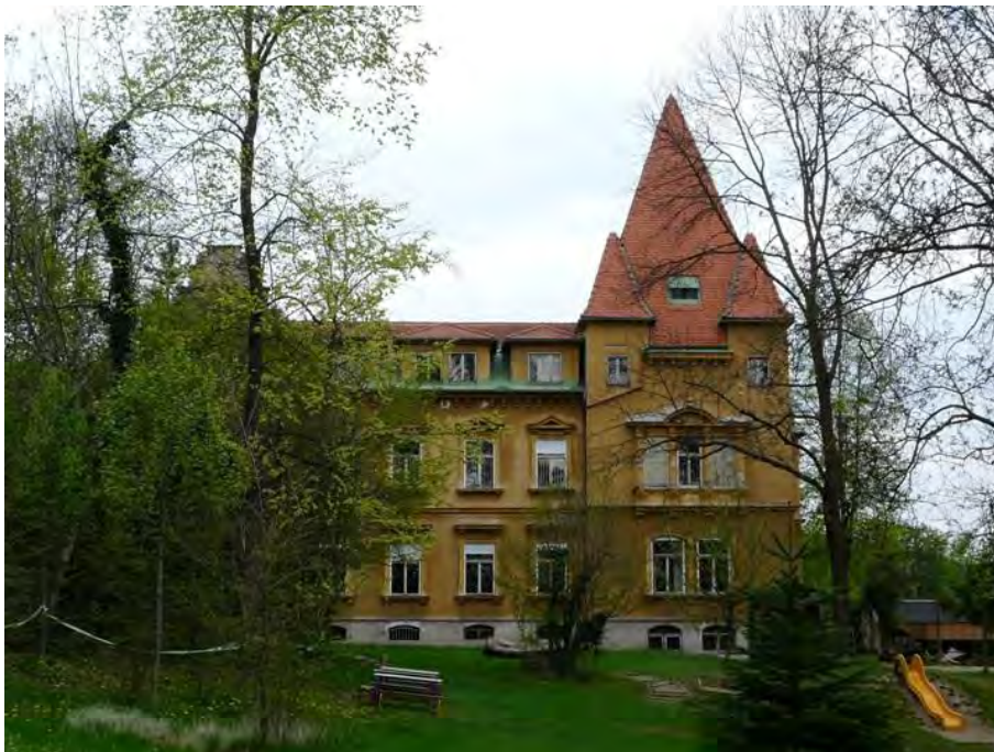
Abb. 103 Ansicht der nach Südwestsüd ausgerichteten Fassade des Testhauses vom 17. April 2011
