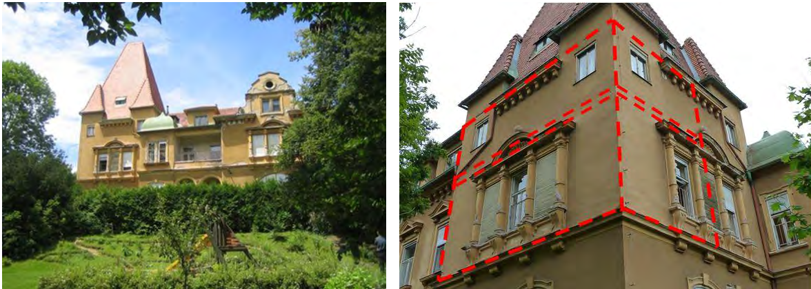
Abb. 1 Südost-Ansicht Kindergarten / Kinderkrippe Schönbrunnngasse 30
