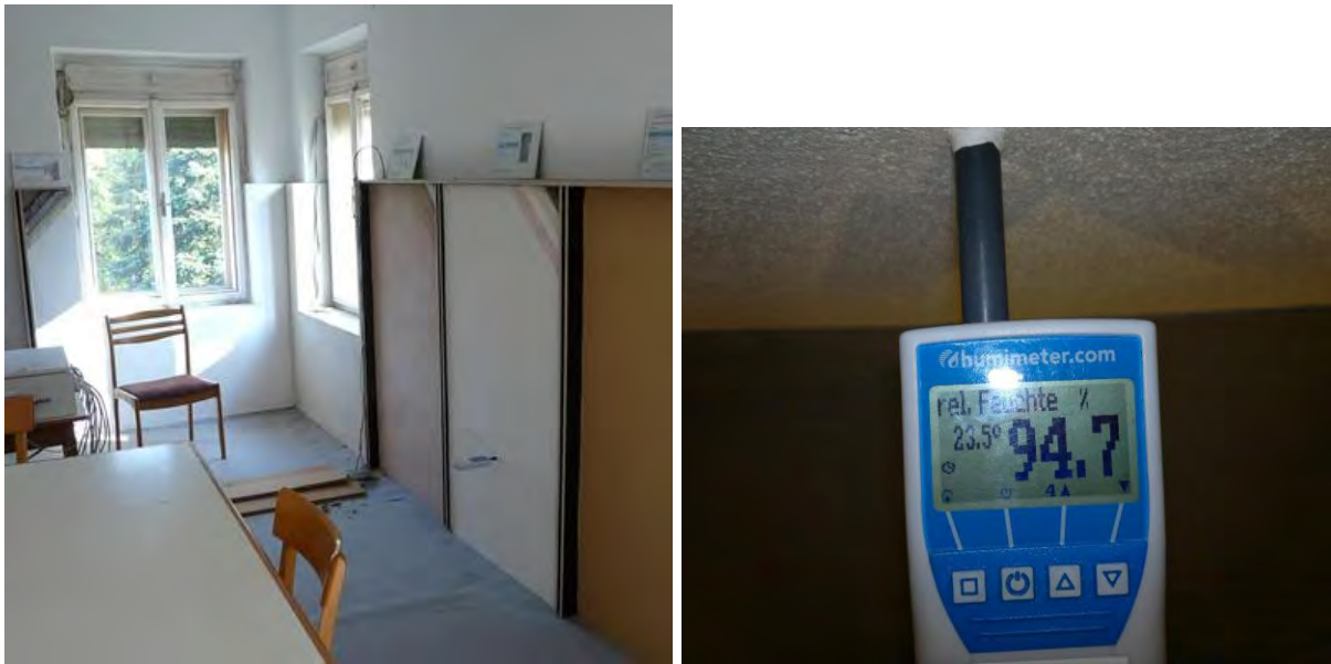
Abb. 56 Ein Handgerät mit Temperatur/Luftfeuchtesensor misst im mit Wärmedämmputz gedämmten Feld die Verhältnisse auf der ehemaligen Bestandsoberfläche
