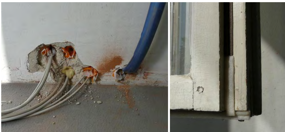
Abb. 49 Links Wanddurchbrüche für Kabel der Messtechnik und für die Wasserversorgungsleitung des Befeuchters, rechts Abdichtung mit (zwei unterschiedlichen) Fensterabdichtungsbändern
