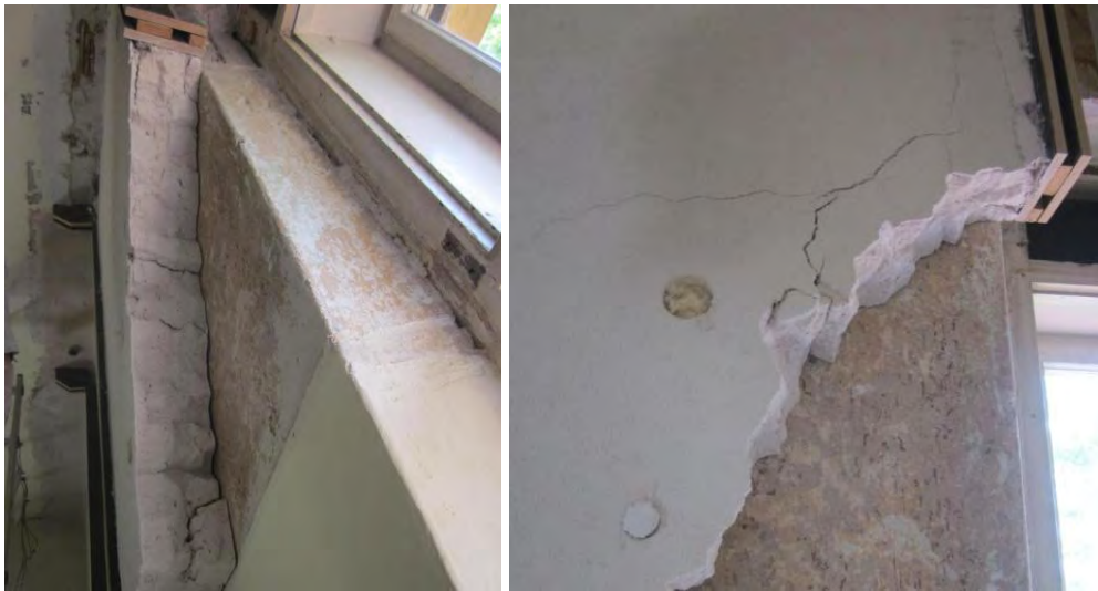
Abb. 28 Abbruch des Dämmputzes: bereits beim ersten Versuch ging zwischen Dämmung und Bestandputz eine Fuge auf, die Dämmung konnte in großen Stücken abgelöst werden
