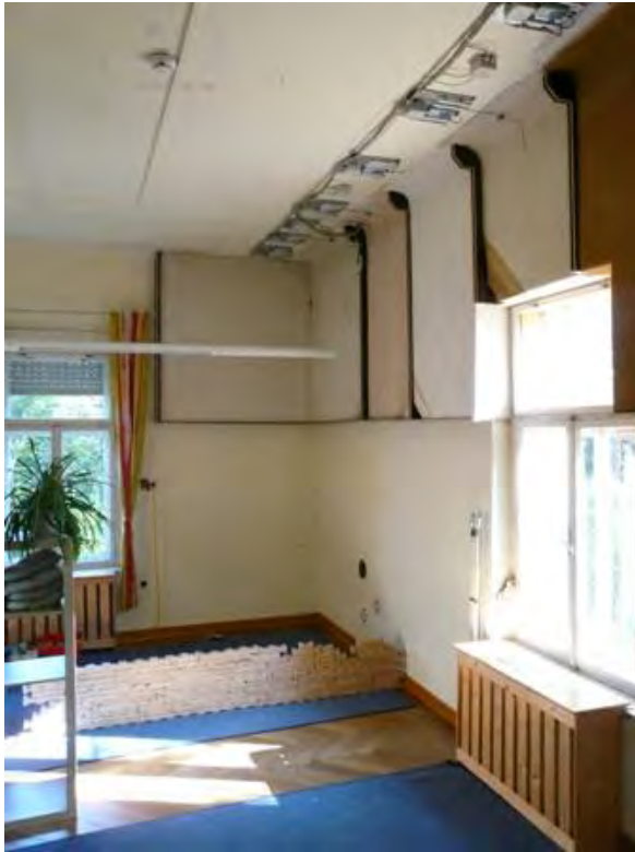
Abb. 20 Gesamtansicht der Dämmsysteme nach Abschluss der Arbeiten im Obergeschoss; von links: Zellulose, Perliteplatte, Thermosilitputz, Holzweichfaserplatten und Schilfmatten
