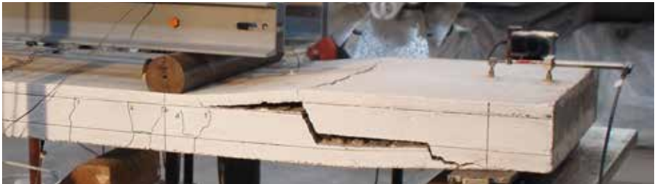
Bild 8: Fugenversagen zwischen der Kernschicht aus Porenleichtbeton und den Deckschichten aus Normalbeton
