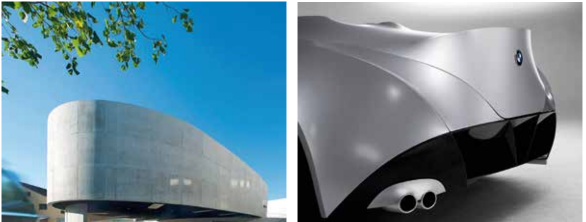
Bild 3: Links: Einsinnig gekrümmte Ortbetonwand beim LAUFEN Forum, dem Besucher- und Präsentationszentrum der Keramik Laufen AG in Laufen [Foto: Nissen & Wentzlaff]; Rechts: Automobildesign als Vorreiter der Architektur. Ästhetik zweisinnig flach gekrümmter Flächen: Gina Design [Foto: Thomas von Salomon, BMW Group]
