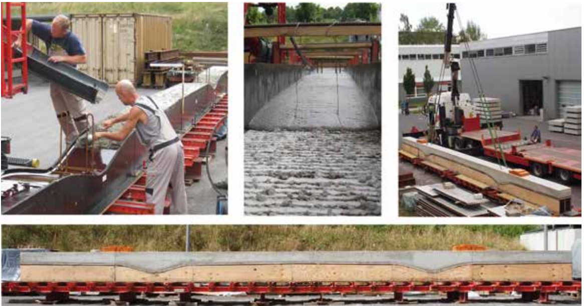
Bild 14: Herstellung eines formoptimierten geschichteten Deckenstreifens: Betonage der untersten und mittleren Schicht, während des Transportes und fertiger Träger [Fotos: Michael Frenzell]
