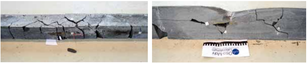
Bild 11: Bruchbild einer quadratischen Stütze (links): Das Versagensbild in Stützenmitte ähnelt dem eines Biegebruchs (Stützenmitte ist durch den senkrecht verlaufenden roten Strich und den DMS markiert). Rechts: Bruchbild einer dreieckigen Stütze mit ausgeprägt erkennbarem Druckzonenbereich in Stützenmitte. [Fotos: Angela Schmidt]
