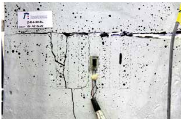
Bild 11: Nach einem Zugversuch: Versagensbild einer Klebverbindung mit schlaufenförmiger Stabstahlbewehrung. Die Übergreifungslänge betrug 9 cm. [Foto: Sebastian Oster]
