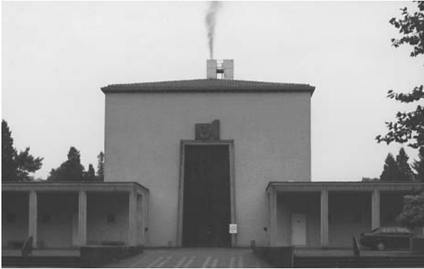
Köln - Westfriedhof 50829 Venloer Straße 1132 Erbaut: 1937 Architekt: Hans Heinz Lüttgen Betreiber: Stadt Köln
