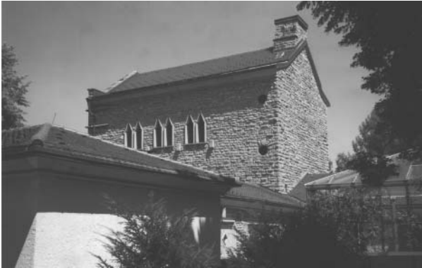
Villingen-Schwenningen – Waldfriedhof 78056 Am Waldfriedhof 15 Erbaut: 1927/28 Architekt: Stadtbaurat Julius Feucht Betreiber: Stadt Villingen-Schwenningen
