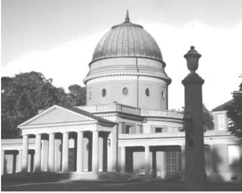
Darmstadt – Waldfriedhof 64293 Am Waldfriedhof 25 Erbaut: 1914 Architekt: Stadtbaurat August Buxbaum Betreiber: 1990 stillgelegt
