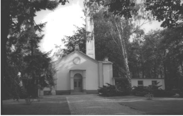
Pößneck - Oberer Friedhof 07381 Am Friedhof 8 Erbaut: 1907-1908 Architekt: Hermann Schilling, Otto Schilling Betreiber: Stadt Pößneck
