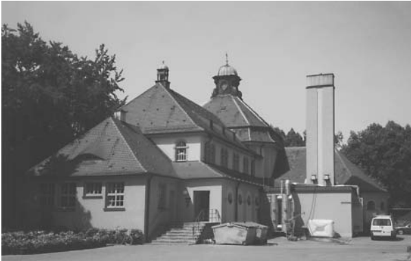
Augsburg – Westfriedhof 86157 Stadtberger Str. 80a Erbaut: 1915 Architekt: Stadtbaurat Otto Holzer Betreiber: Stadt Augsburg
