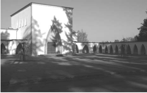
Forst/Lausitz – Zentralfriedhof 03149 Gubener Straße 102 Erbaut: 1930 Architekt: Stadtbaurat Rudolf Kühn Betreiber: Stadt Forst
