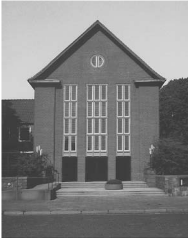
Kiel - Alter Urnenfriedhof 24116 Eichhofstraße 48-52 Erbaut: 1916 Architekt: Oskar Hoff Betreiber: Feuerbestattungsverein Schleswig-Holstein w. V.
