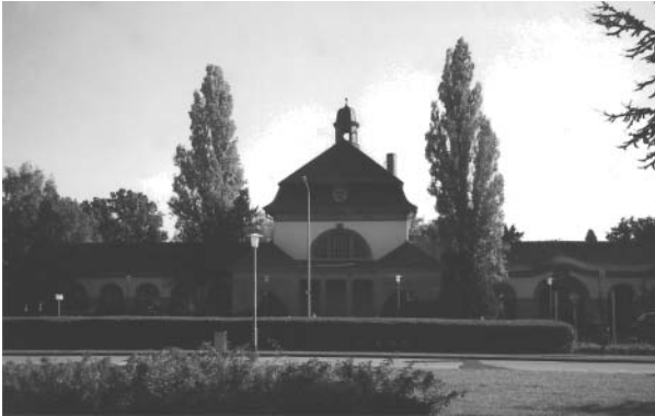
Wiesbaden – Südfriedhof 65189 Siegfriedring 25 Erbaut: 1908/1912 Architekt: Stadtbaumeister A. O. Pauly, Stadtbaurat Frobenius, Bruno Engels, Heinrich Döring, H. Diehl Betreiber: Stadt Wiesbaden
