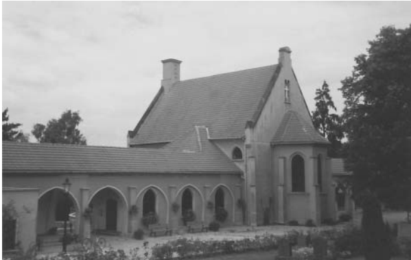
Naumburg – Städtischer Friedhof 06618 Weißenfeller Str. 67 Erbaut: 1933/34 Architekt: Stadtbaurat Paul Schröter Betreiber: 1976 stillgelegt
