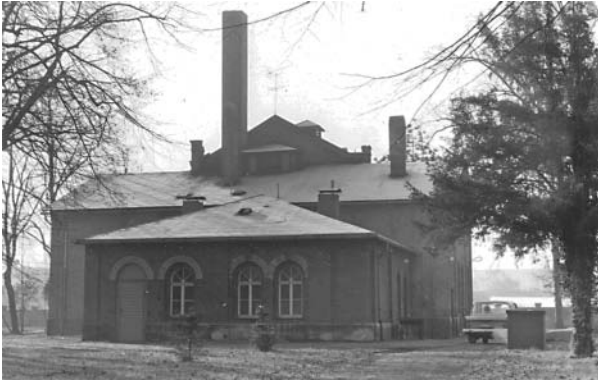
Arnstadt – Friedhof 99310 Am Friedhof 2 Erbaut: 1924 Architekt: Stadtbaurat Anton Acker, Firma Topf & Söhne Betreiber: 1994 stillgelegt, Abbruch der Öfen 2007
