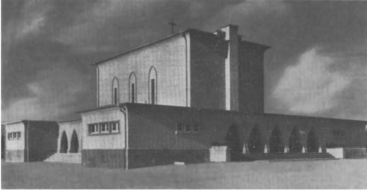
Mühlhausen/Thüringen – Neuer Friedhof 99974 Eisenacher Landstraße 14 Erbaut: 1928/29 Architekt: Karl Theodor Hus Betreiber: 2000 stillgelegt
