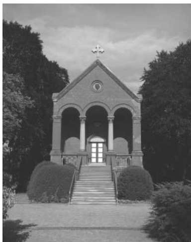
Bremerhaven - Friedhof Wulsdorf 27572 Weserstraße 169 Erbaut: 1930 Architekt: Stadtbaurat Julius Hagedorn Betreiber: 1990 stillgelegt
