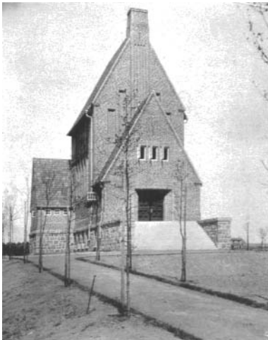
Lübeck - Vorwerker Friedhof 23554 Friedhofsallee 83 Erbaut: 1909/10 Architekt: Carl Mühlenpfordt Betreiber: Stadt Lübeck
