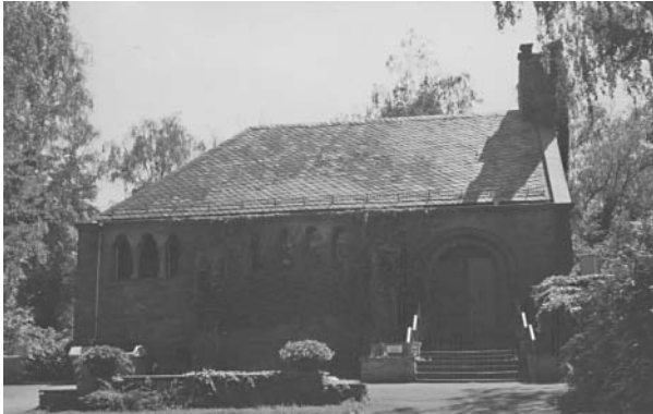
Karlsruhe – Hauptfriedhof 76131 Karl-Wilhelm-Haid- und Neustraße 35–39 Erbaut: 1903 Architekt: August Stürzenacker Betreiber: Stadt Karlsruhe, stillgelegt 1998
