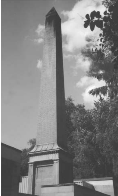
Esslingen – Ebershaldenfriedhof 73728 Landenberger Str. 50 Erbaut: 1913 Architekt: Hermann Klotz Betreiber: Stadt Esslingen
