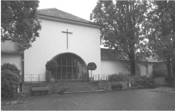
Kassel – Hauptfriedhof 34127 Tannheckerweg 6 Erbaut: 1926/27 Architekt: Max Hummel, Ernst Rothe Betreiber: 2000 stillgelegt
