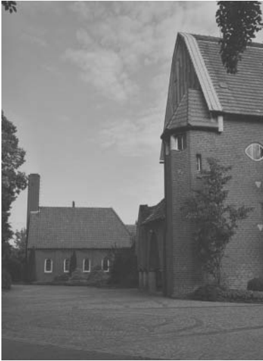
Wilhelmshaven – Friedhof 26386 Friedensstraße 45 Erbaut: 1926 Architekt: Stadtbaurat Hermann Zopff Betreiber: vermutlich 1982 stillgelegt
