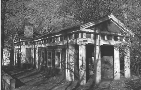
Grünberg / Schlesien – Friedhof Zielona Góra (Polen) – Park Tysiaclecia Wazów Erbaut: 1923 Architekt: vermutlich Wilhelm Nerchen Betreiber: stillgelegt
