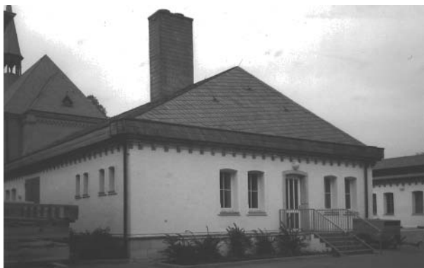
Magdeburg – Westfriedhof 39110 Große Diesdorfer Straße 160 Erbaut: 1923 Architekt: Stadtbaurat Bruno Taut, Magistratsbaurat Johannes Göderitz Betreiber: Stadt Magdeburg
