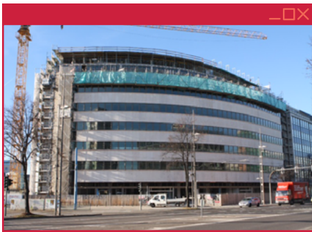
Das Kaufhaus Schocken im Umbau 2012
