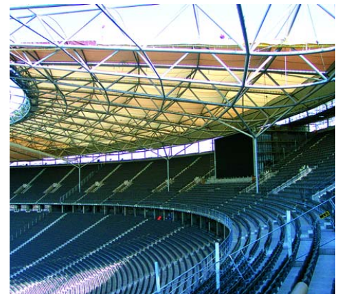
Abb. 1 (oben) und 3: Korrosionsschutz von Stahlbauten
