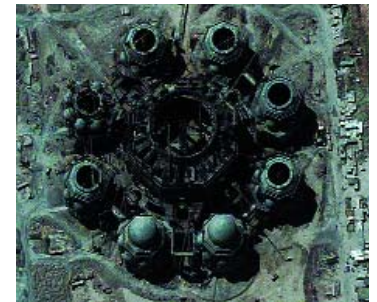
📷 Bau einer Moschee in Bagdad, Satellitenbildaufnahme
