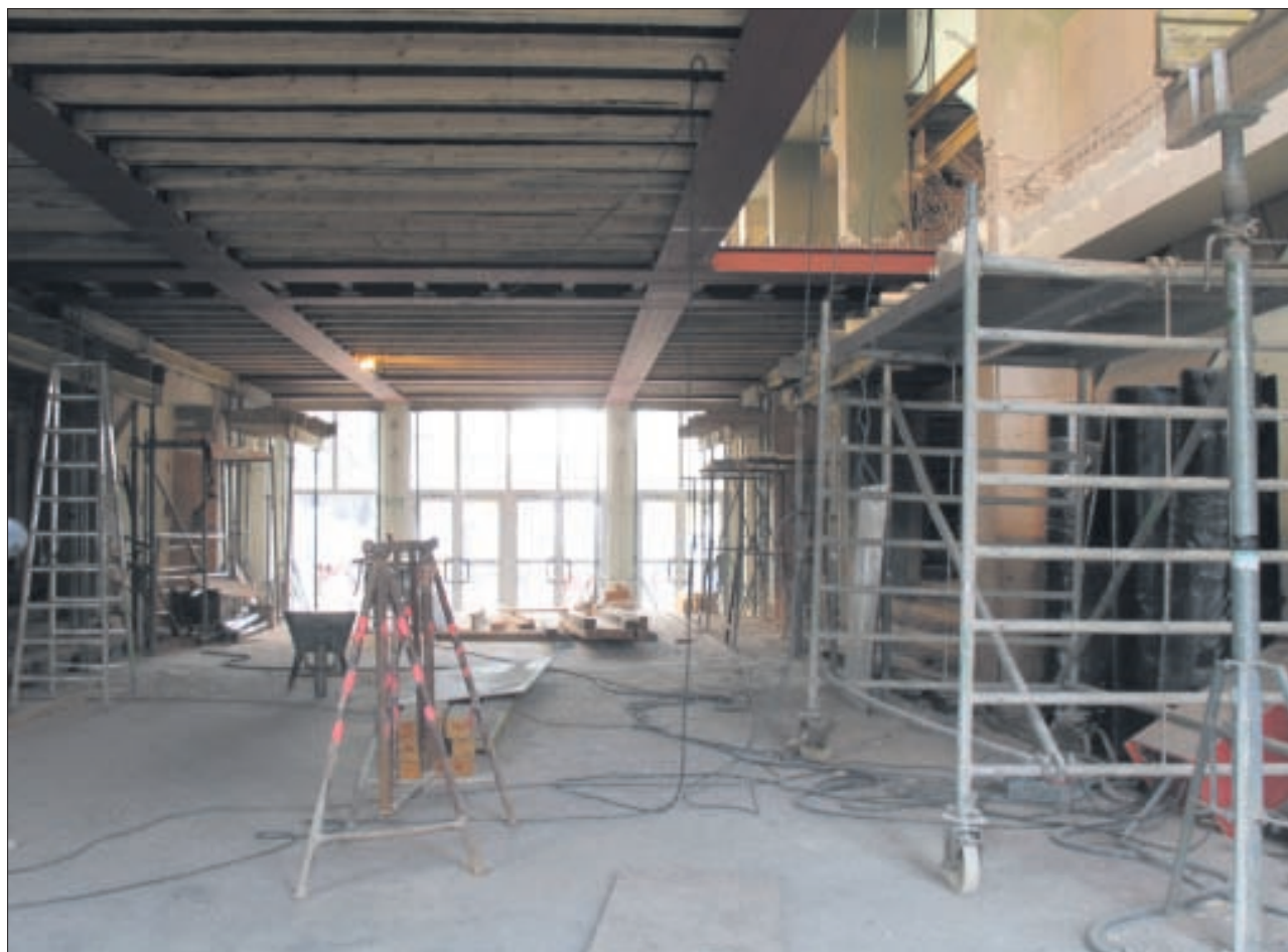
Derzeit werden auch im Foyer des Trefftz-Baus Abbruch- und Rohbauarbeiten erledigt. Künftig wird dieser Bereich durchgehbar und nach oben offen sein. Foto: UJ/Geise
