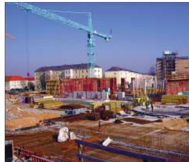
Nöthnitzer Straße, Blick von der Südseite (Sporthallen): Die verschränkte Form des künftigen Gebäudes der Fakultät Informatik nimmt langsam Gestalt an und beginnt, über den Keller hinauszuwachsen. Rechts im Hintergrund ein Teil des Barkhausen-Baus mit dem Heinz-Schönfeld-Hörsaal.
