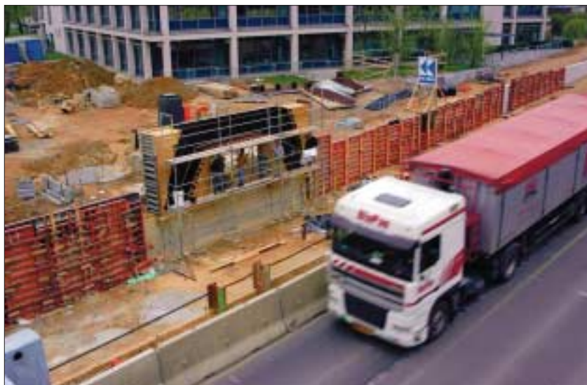
Bergstraße – von Gerber-Bau/Neue Mensa/Hörsaalzentrum: Die Arbeiten an der künftigen treppen- und hindernisfreien Brückenquerung über die abgesenkte Bergstraße haben begonnen. Im Foto sichtbar ist ein Rumpf eines künftigen Brückenkopfes sowie – neben der alten Straßenführung – das zum Teil schon abgesenkte Bett der künftigen Straße. Fotos (3): UJ/Geise
