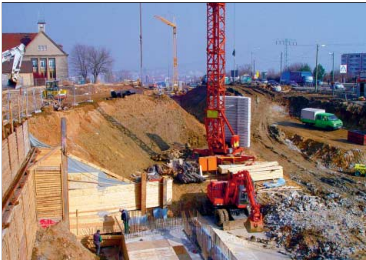
Lärm, Dreck, Umleitungen: Von den Anliegern im oberen Bereich der Bergstraße, wie dem TU-Institut für Landmaschinen (im Foto links), verlangt der Ausbau der Straße zum Autobahnzubringer einiges ab. Foto: UJ/Eckold
