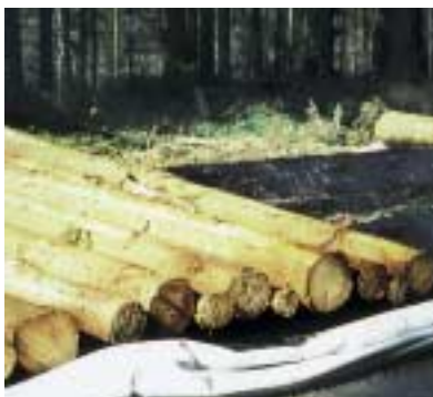
Auf zwei Lagen Folie werden die Baumstämme gelegt.
