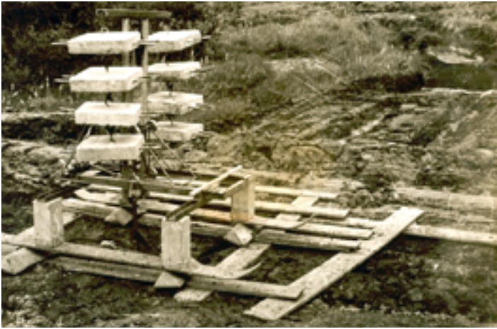
EINSINKVERSUCHE MIT PANZERKETTEN, UNIVERSITÄTSARCHIV DER TU DRESDEN, FOTOARCHIV.
