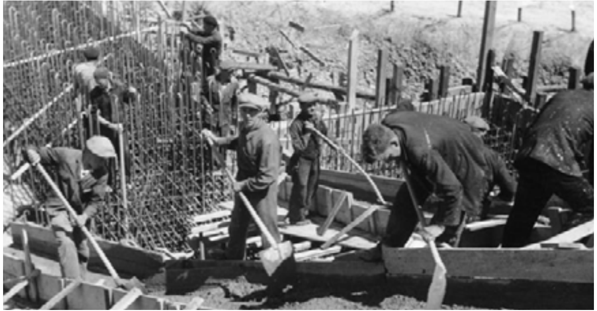
BETON-ARBEITEN AM ATLAN- TIKWALL, SOMMER 1942, BUNDESARCHIV/BILDARCHIV.
