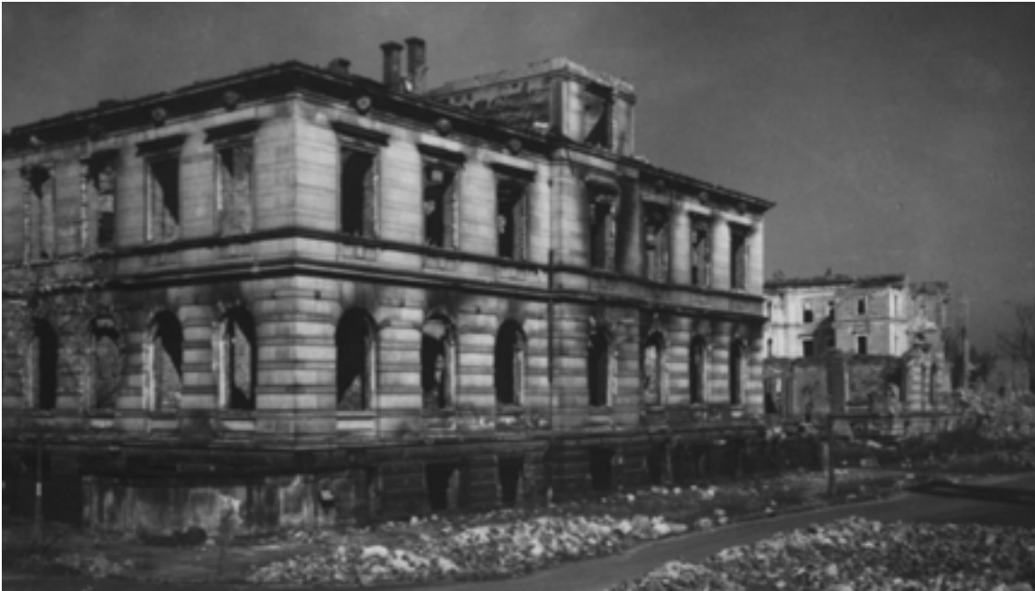
ZERSTÖRTES GEBÄUDE AUF DEM GELÄNDE DER TH DRESDEN, UNIVERSITÄTSARCHIV DER TU DRESDEN, FOTOARCHIV.
