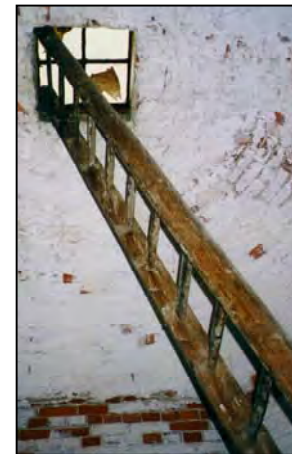
Bild 28 Leiter 1 - zum Deckengewölbe
