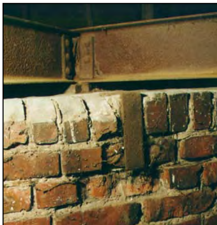
Bild 23 Mauerwerksklammer Ecke E1 (Nordost)
