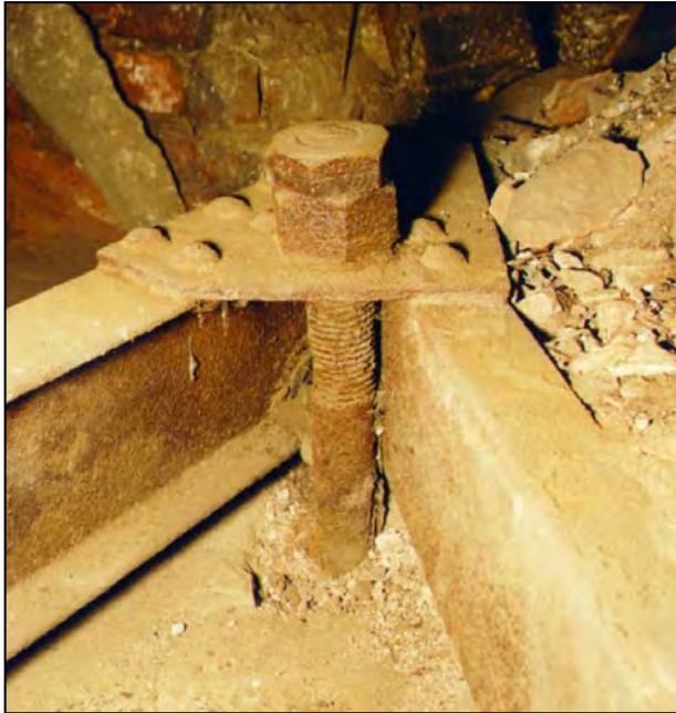
Bild 24 Detail Zuganker
