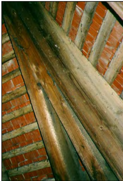
Bild 35 Verschneidung Gratsparren und Sparren
