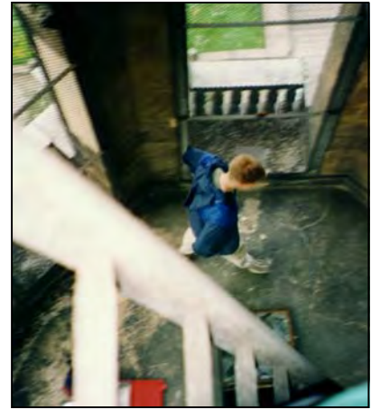
Bild 31 Leiter 2 – Blick auf das Gewölbe
