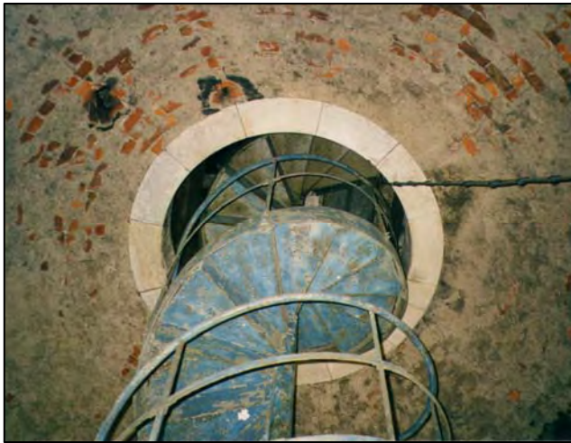
Bild 12 Durchführung der Spindeltreppe
