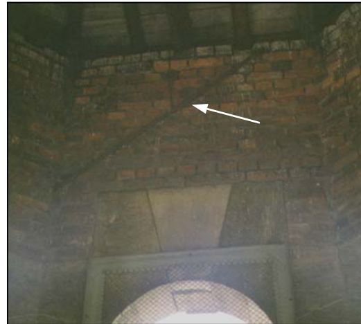
Bild 45 noch vorhandene Zugstange
