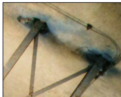
Bild 27 Auflager der I-Träger oberhalb des Glockenstuhles
