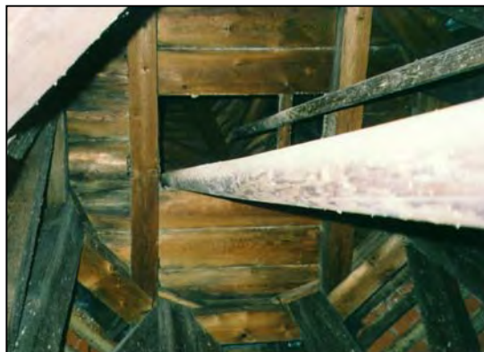
Bild 37 Holzdielung in Ebene des Laternenfußpunktes
