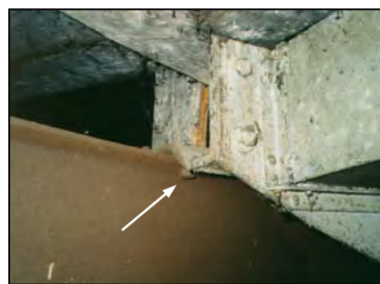
Bild 26 Schraubverbindung zu Trägerrost
