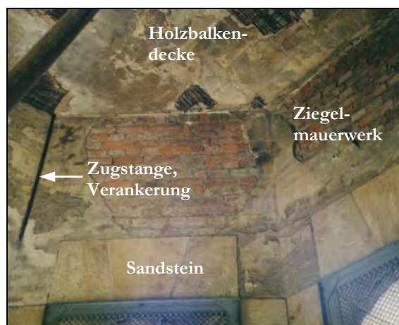
Bild 29 Mauerwerk und Holzbalkendecke
