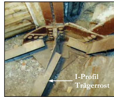
Bild 19 Anschlußpunkt Trägerrost – Fach- werkkonstruktion
