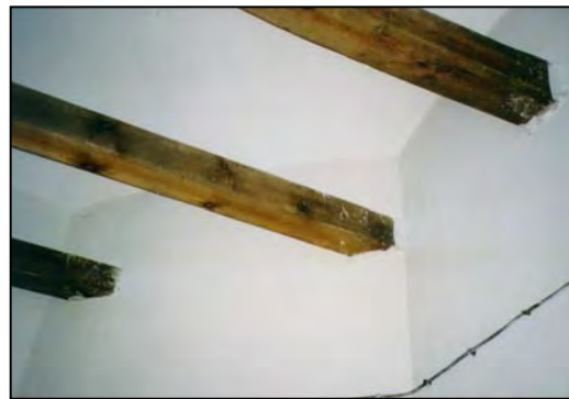
Bild 43 Holzbalken im Turmzimmer
