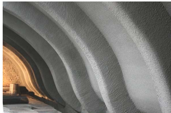
(c) Verstärkung einer Tonnenschale in Zwickau
