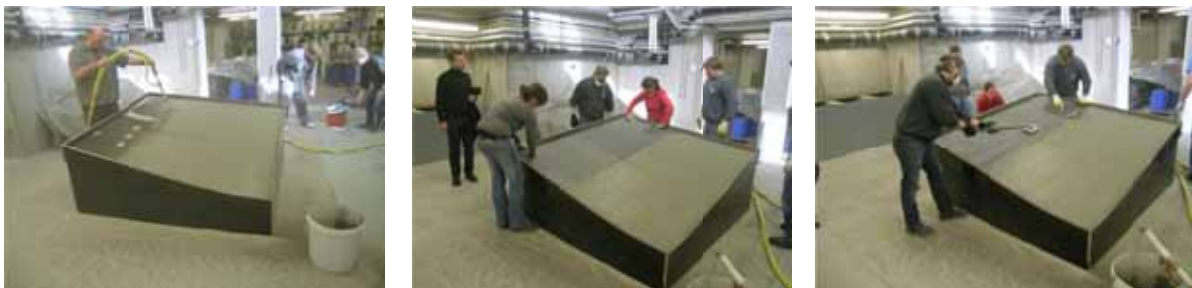
(a) Aufspritzen der ersten Lage Beton (b) Einlegen der Bewehrung (c) Andrücken der Bewehrung (a) Spraying the first concrete layer (b) Lay-up of the reinforcement (c) Pressing on of the reinforcement
