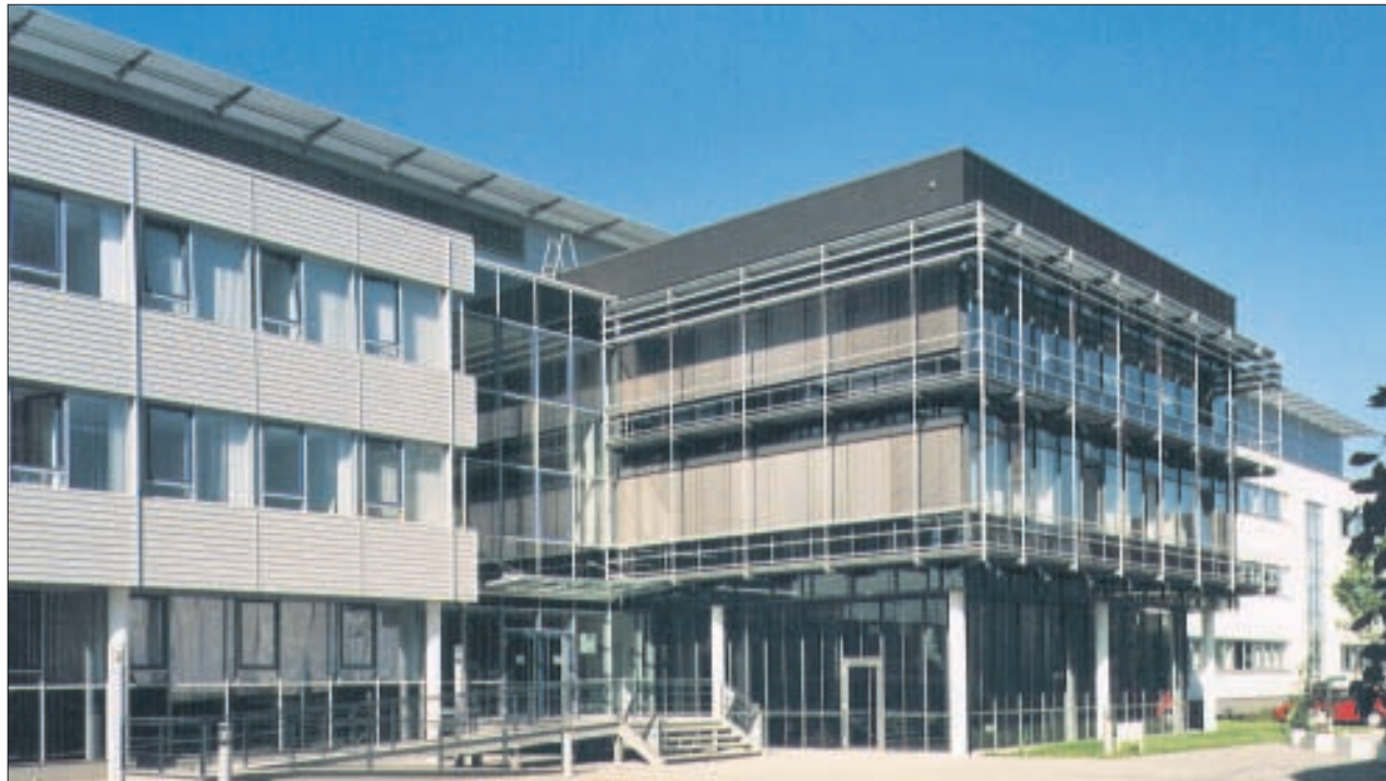
Der Dresdner Standort des Fraunhofer-IKTS an der Winterbergstraße.
