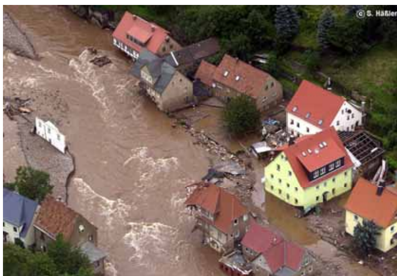
Abb. 1.1: Vom Hochwasser zerstörte Häuser, Weesenstein August 2002 (Foto: Stefan Häföler)
