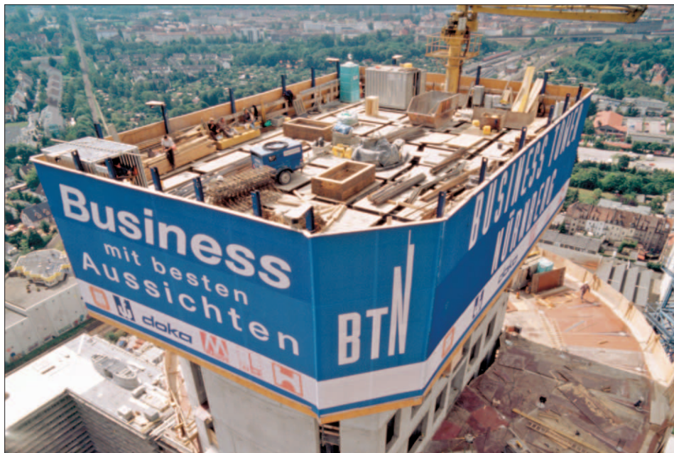
Bild 3. Lagerflächen auf einer selbstkletternden Schalungs- und Arbeitsplattform auf dem Versicherungsgebäude Nürnberg (Quelle: www.doka.de)
