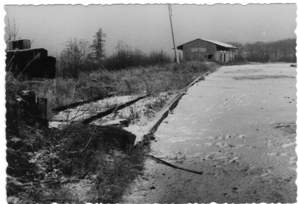
»Dieselbe Bahnstrecke heute« Buchenwald, Bahnhof, 1961
