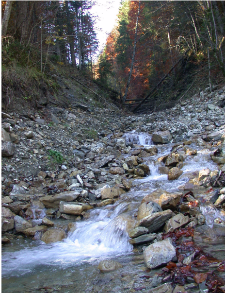
Abb. 5-6: Sperrgraben in Pegelnähe am Einfluss in die Halbammer
