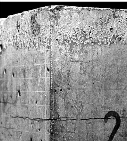
**Bild 59** Leichte Entmischungen, Betonoberseite PK 16, B 3/II-1
