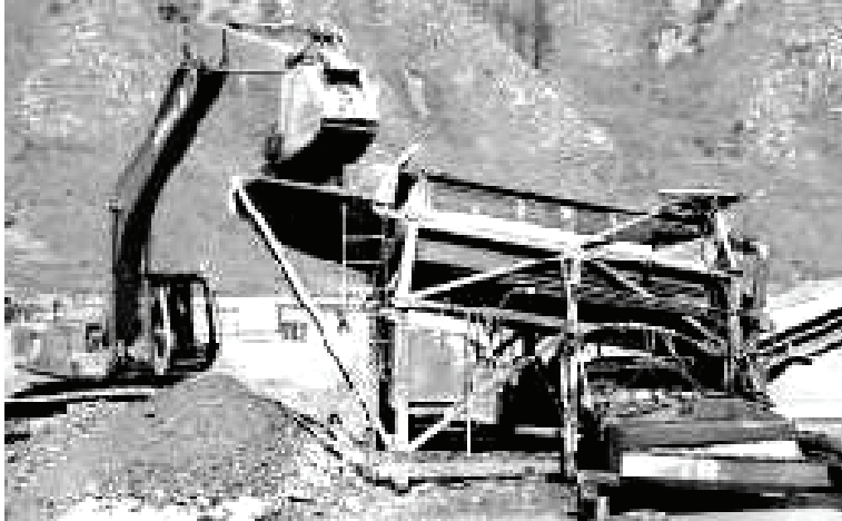
Bild 12: Bagger und Waschtrommel der neuseeländischen Bergbaufirma am Yalbag
