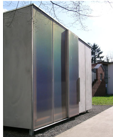
(b) Fertiges Gebäude
