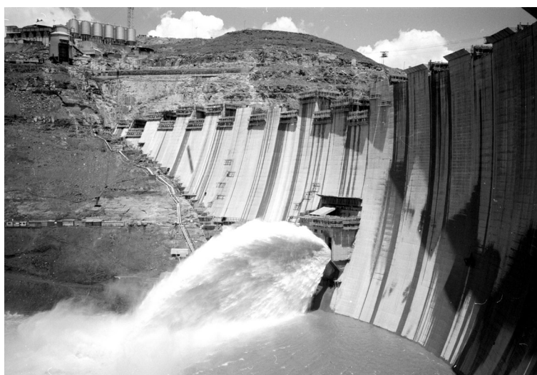
Abb. 1: Katse-Staumauer in Lesotho während der Errichtung.
