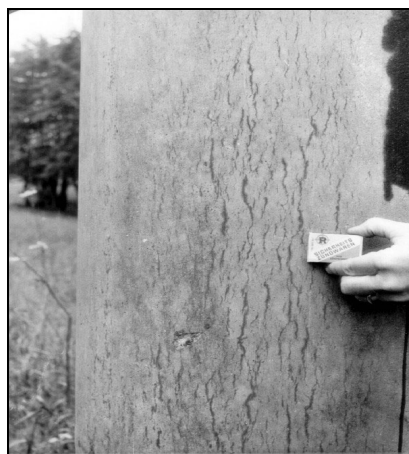
Abb. 1: Beispiele von Stahlbetonbauteilen mit Rißschäden im Alter von wenigen Jahren (links) oder wenigen Wochen (rechts)
