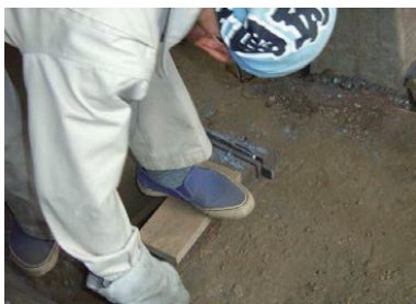
写真3-6 地金を挟んで右手で締める
