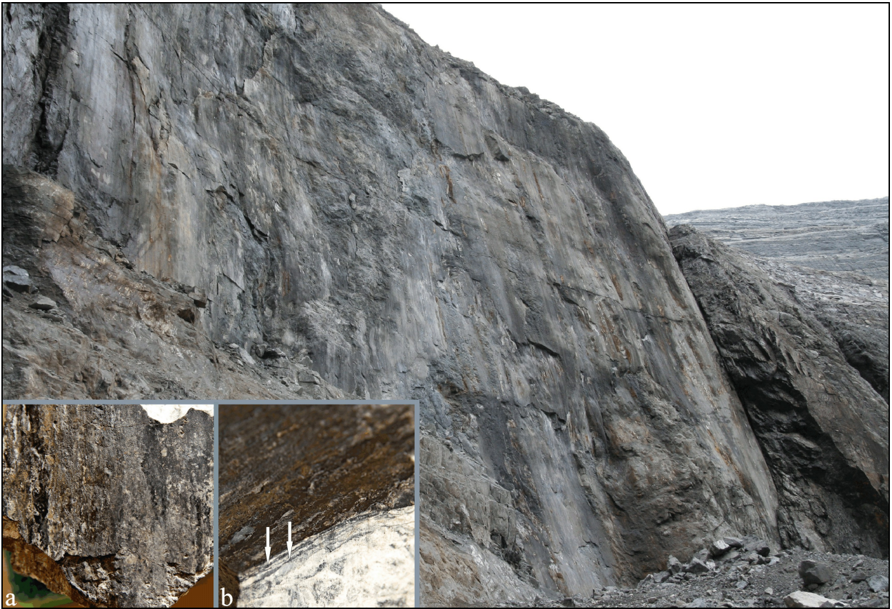
Рис. 1. Плоскость разлома с зеркалами скольжения, открывшаяся после обвала в сверхглубоком карьере алмазоносной трубки «Удачная» (Республика Саха).
