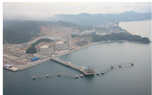
Figure 4 An LNG Unloading Facility at Guangdong LNG Terminal China
