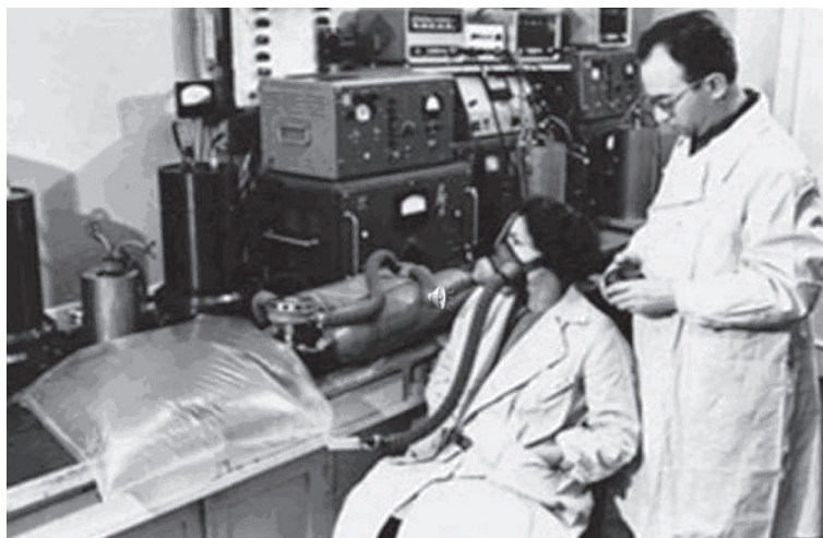
Определение содержания радия в организме человека по интенсивности выдыхания радона. Автор разработки В.Д. Спиринов и техник Т.М. Григоренко
