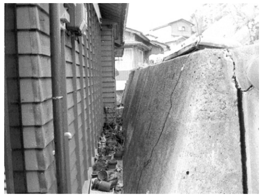
写真5 重力式コンクリート擁壁
