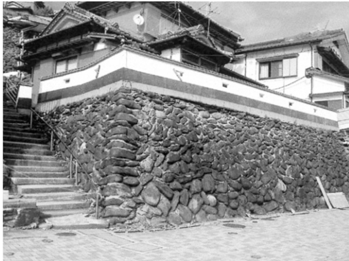
写真12 健全な擁壁の上の建物
