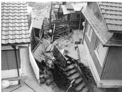
写真9 擁壁の崩壊による道路閉塞
