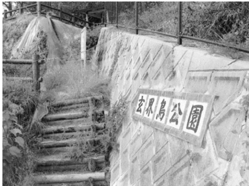
写真4 コンクリートブロック擁壁
