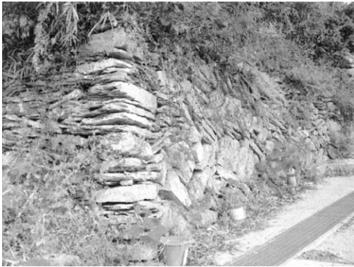
写真2 空石積み擁壁
