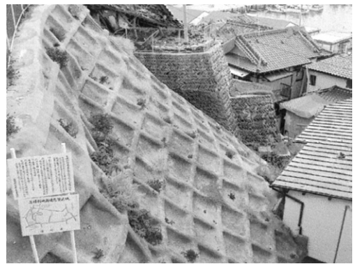
写真7 斜面の保護工
