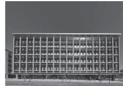
竣工した本館外観
