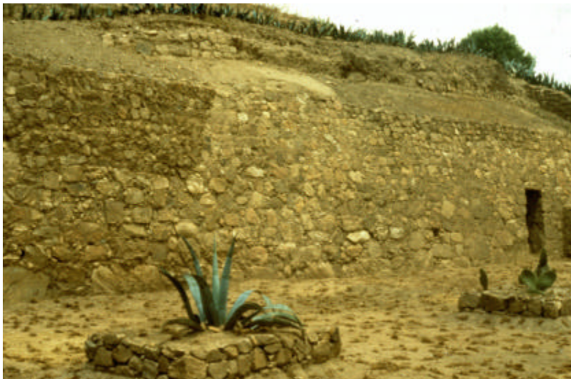
Fig. 7 El muro de contención de la plataforma inferior de la fase Huacaloma Tardío
