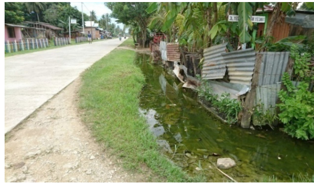
Gambar 3. Saluran air di kampung Bondek menjadi tempat perindukan nyamuk, karena tidak ada jaringan pembuangan
