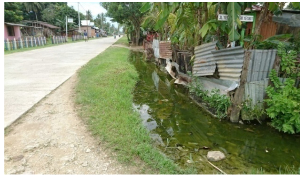
Gambar 3. Saluran air di kampung Bondek menjadi tempat perindukan nyamuk, karena tidak ada jaringan pembuangan
